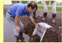
落口の調整作業
