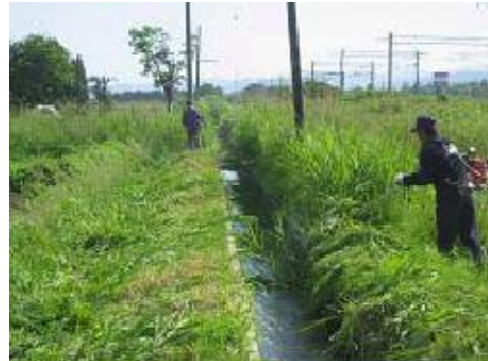
水路周辺の草刈り
