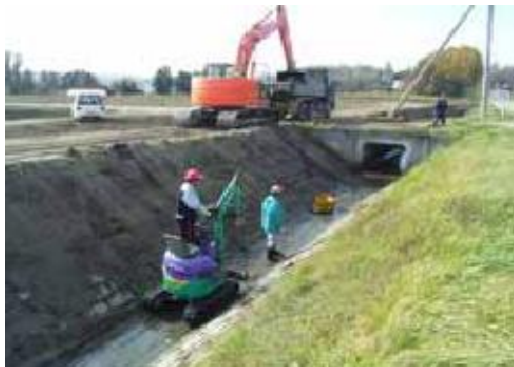
水路の土砂上げ
