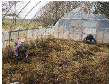
ビニルハウス設置
