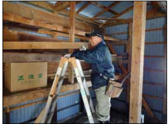
内壁の間柱設置中
