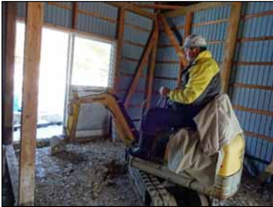
基礎束石埋設のため掘削中
