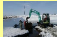
排水調整池の土砂の除去
