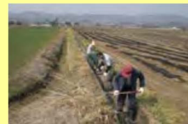
水路の泥上げ
