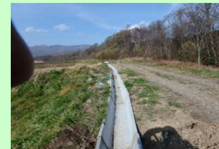
施工後の状況
