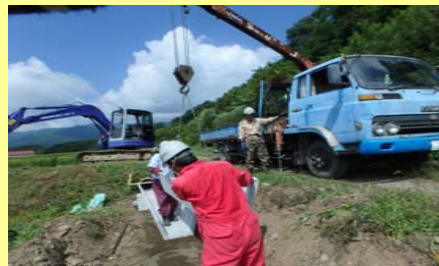
トラフの設置状況
