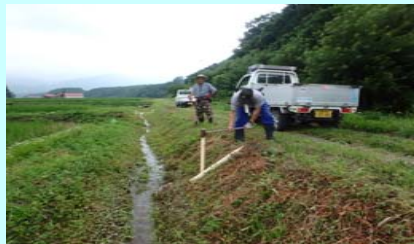
断面の復旧状況
