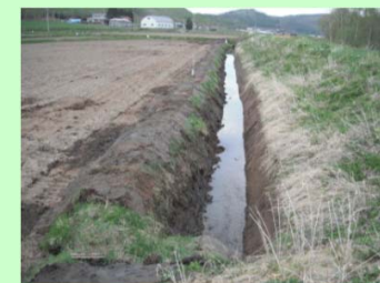
泥上げ実施後の水路
