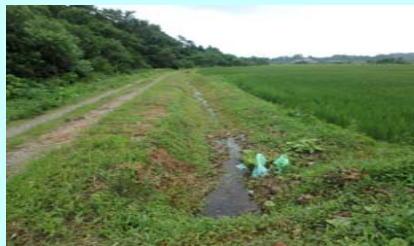
土水路の状況
