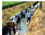
水路の泥上げ
