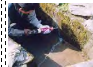
水路のひび割れ補修
