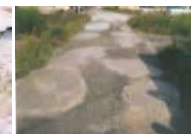
農道の窪みの補修
