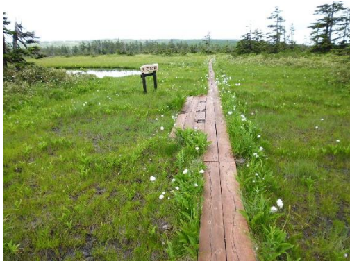
防腐処理を施した木道
