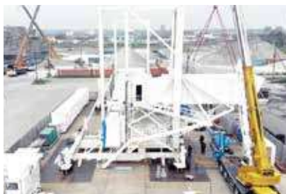
▲工場外(港)での組立
