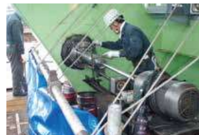
▲自社製現地アンローダー穴ボーリング用治具
