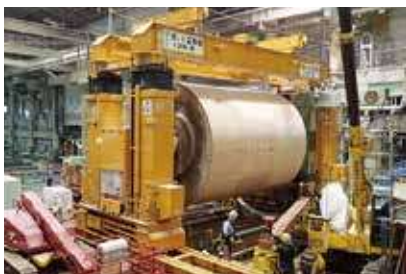
▲機械据付、解体
