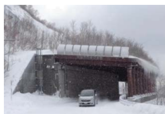
シェッド (洞爺湖登別線 オロフレ第4覆道)
