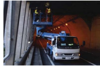
シェッド点検状況
