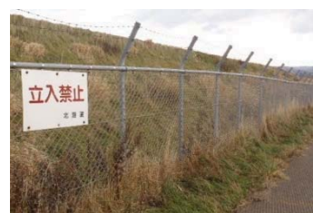
場周柵(奥尻空港)
