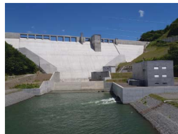
ダム・貯水池 (シューパロ発電所)
