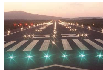
照明施設(紋別空港)
