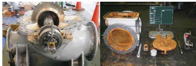
ポンプ設備の分解補修
