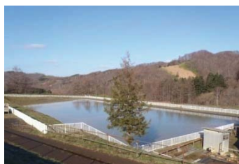
沈殿池(伊達鉱山)
