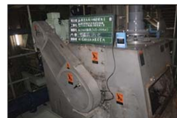
スラム分離器点検状況
