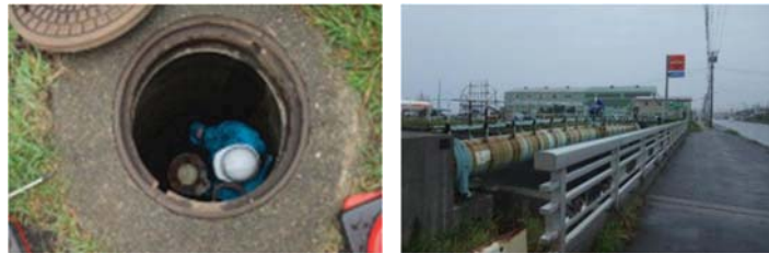
配水管の点検
