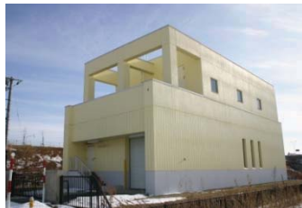
中継ポンプ場
