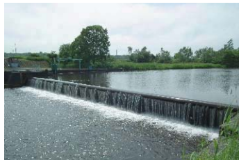
取水施設 (苫小牧地区工業用水道)
