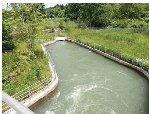
水路[沈砂池] (滝の上発電所)
