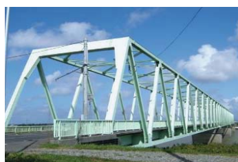
橋梁 (江別奈井江線 石狩大橋)
