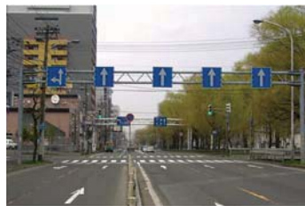
大型道路標識(オーバーヘッド)
