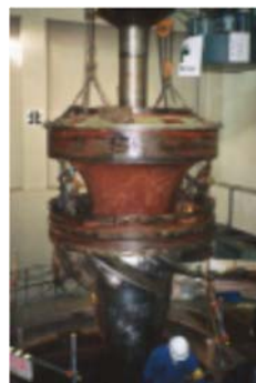
水車発電機分解点検補修
