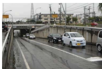
大型カルバート (美瑛達布岩見沢線西 10 丁目立体交差)
