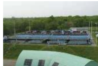
浄水場 (苫小牧地区工業用水道)
