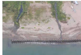
離岸堤 (忠類港海岸(標津町))
