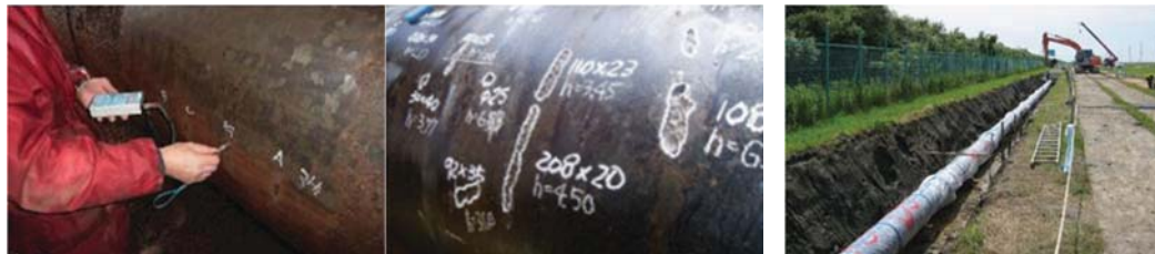
配水管の老朽診断状況
