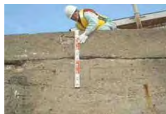
護岸の点検状況
