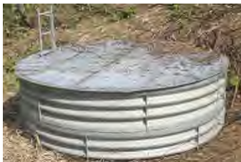
地すべり防止施設 幌新地区(沼田町)
