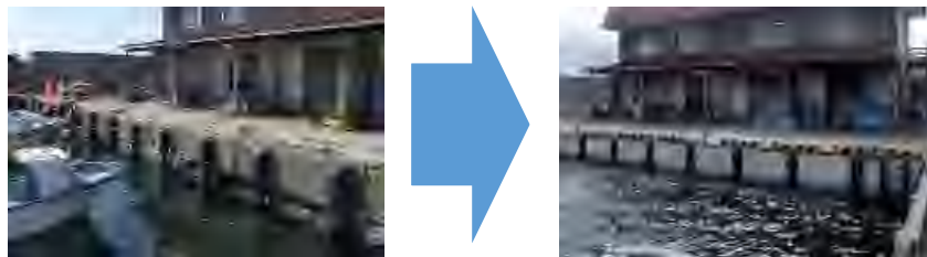
係船岸の施設の修繕状況
