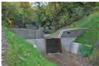
治山ダム (厚真町)
