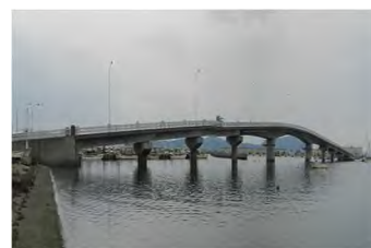
輸送施設 橋梁 第1種 栄浦漁港
