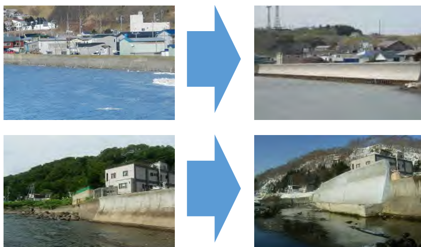
護岸の修繕状況
