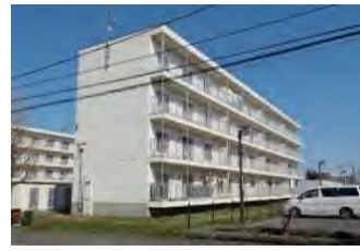
職員住宅(札幌市)
