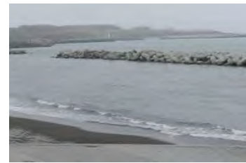
離岸堤 沢木漁港海岸（雄武町）
