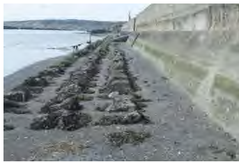
護岸 厚岸漁港海岸（厚岸町）
