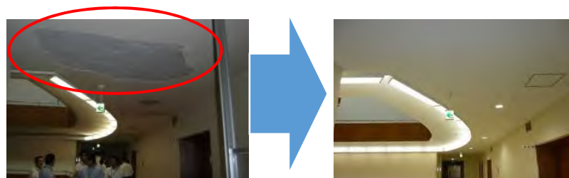
天井(しっくい)剥落の補修
