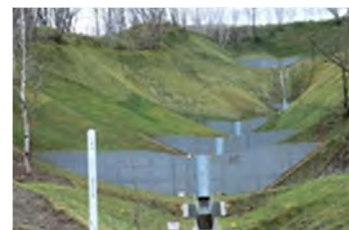
土留工 (遠別町)
