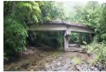
林道橋梁 女那川線 村上橋（函館市）
