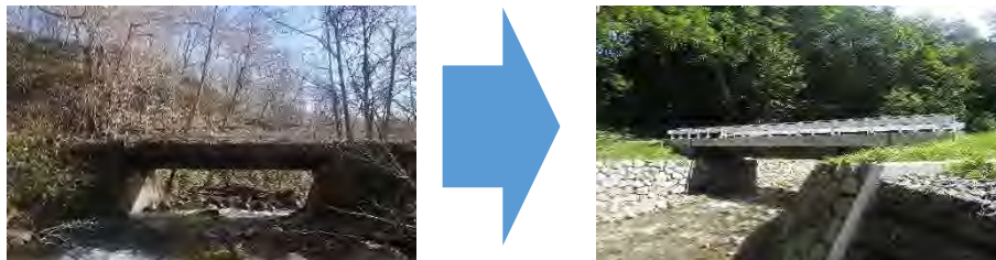
林道橋梁の架替え
