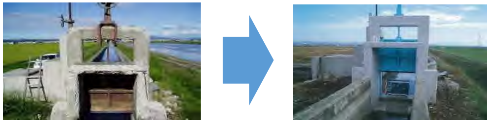
老朽化した用水路の補修状況
