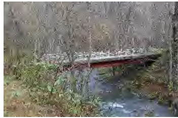
林道橋梁 砂金沢線 金溪橋（新十津川町）
