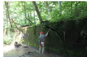
点検・診断状況
