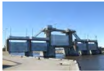
水門 琵琶瀬漁港海岸（浜中町）
