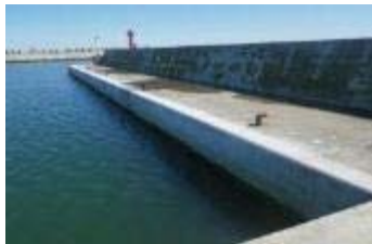
外郭施設 防波堤 第2種 頓別漁港
