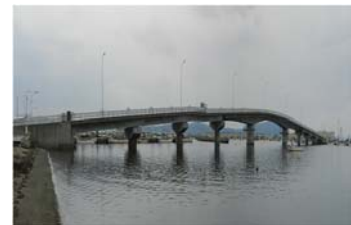
輸送施設 橋梁 第1種 栄浦漁港
