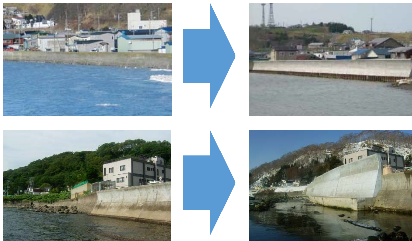
護岸の修繕状況
