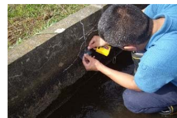
水路における コンクリート診断状況
