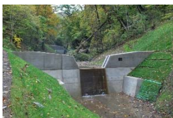
治山ダム (厚真町)
