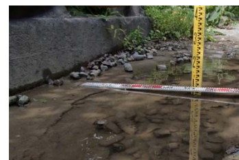
林道橋梁の点検状況 （橋面の土砂堆積状況）
