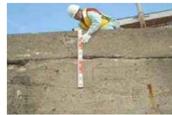
護岸の点検状況
