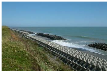
海岸保全施設 浜大樹地区(大樹町)
