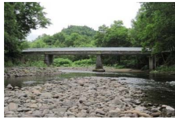
林道橋梁 オヒツ線 第 1 号橋（雄武町）
