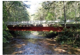
林道橋梁 常五郎林道 緑風橋（函館市）
