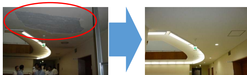
天井(しっくい)剥落の補修
