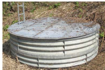
地すべり防止施設 幌新地区(沼田町)
