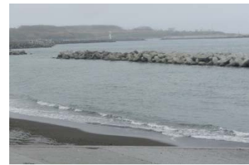
離岸堤 沢木漁港海岸（雄武町）
