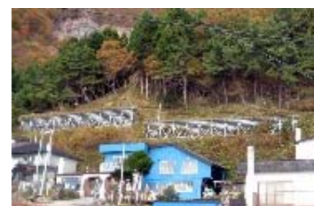
落石防止工 (函館市御崎地区)
