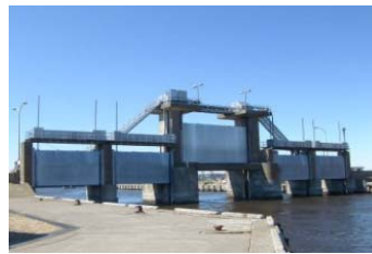
水門 琵琶瀬漁港海岸（浜中町）
