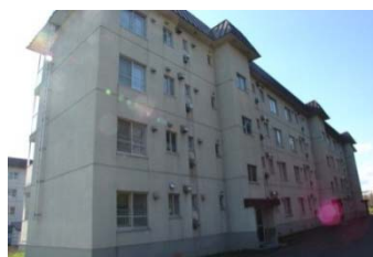
職員住宅(旭川市)
