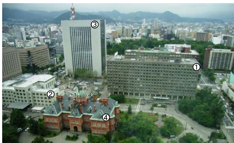
① 庁舎等 (北海道庁本庁舎) ② 庁舎等 (北海道議会庁舎) ③ 警察施設 (北海道警察本部庁舎) ④ 文化財等 (赤れんが庁舎)
