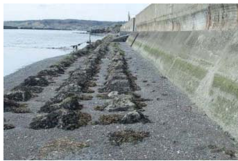
護岸 厚岸漁港海岸（厚岸町）
