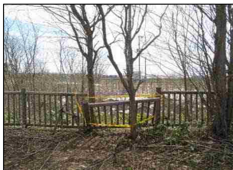
写真① 立ち入り禁止の措置 (石狩川水系早苗別川<江別市>)
