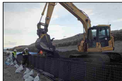
写真④ 仮設道路設置 (小清水海岸<小清水町>)
