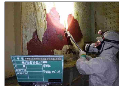
写真③ 塗膜除去 (小樽定山溪線<小樽市>)
