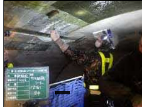
写真④ 剥落防止工事 （忠別清水線<新得町>）
