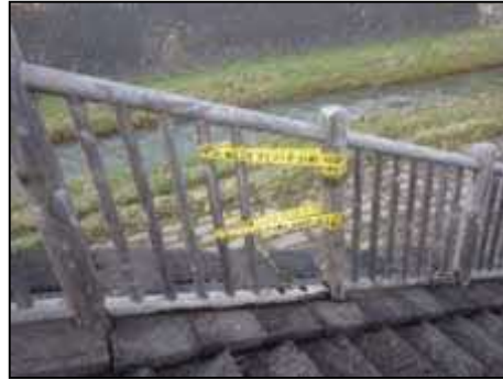
写真① 破損箇所の応急措置を実施 （安平川水系安平川<安平町>）
