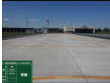
写真② エプロン改良工事 （女満別空港<大空町>）
