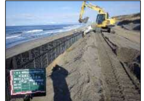
写真⑤ 新技術による仮設工 （小清水海岸<小清水町>）
