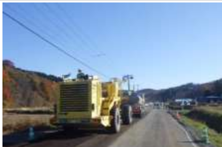
【施工】スタビライザによる破碎・混合
