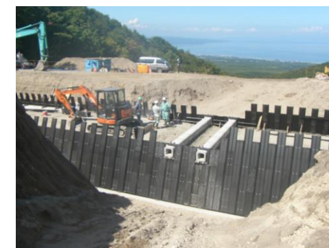
内部材設置状況
