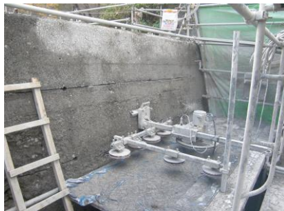
コンクリート堰堤の切断
