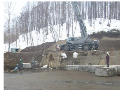
根固ブロック布設
