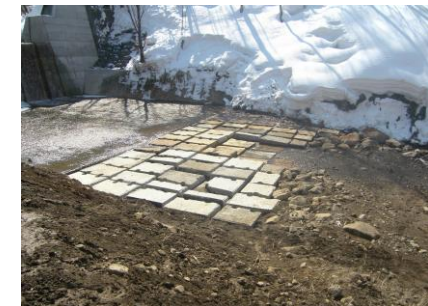
根固ブロック完了
