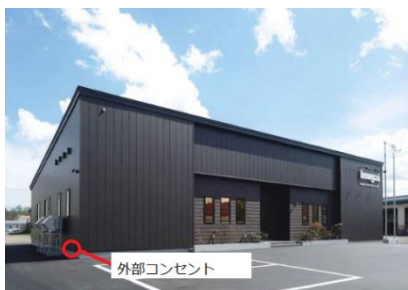
EV導入を見据え、社屋に外部 コンセントを設置<宣誓項目(8)>
