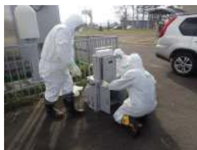
<可搬型モニタリングポストの設置>
